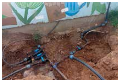
Instalação sistema de rega
