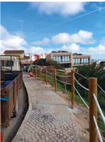
Colocação de postes e cordas
